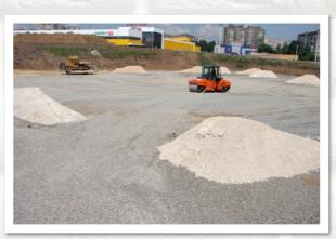
В июне завершены работы по подготовке котлована. Конечные размеры котлована составили 64х84 м, глубина в низшей точке — 5,65 м. Существующий природный рельеф местности, в частности, значительный перепад высот на строительной площадке, позволил распланировать весь грунт на более низменных участках, выровняв таким образом весь участок и уменьшив стоимость работ за счет экономии на вывозе земли.
